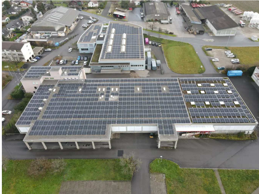
Die neue Photovoltaikanlage wird im nächsten Jahr in Betrieb genommen. zvg
